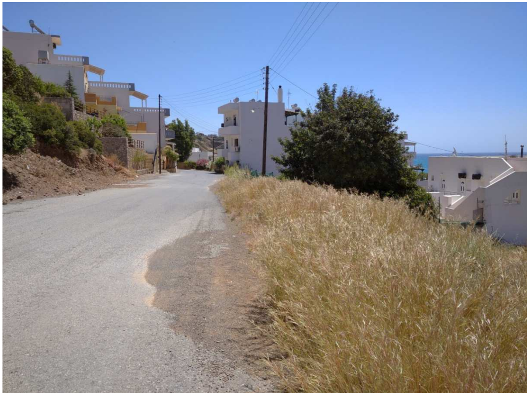
Κατασκευή πεζοδρομίων από την δεξιά πλευρά (νότια) και τοποθέτηση παγκάκια
