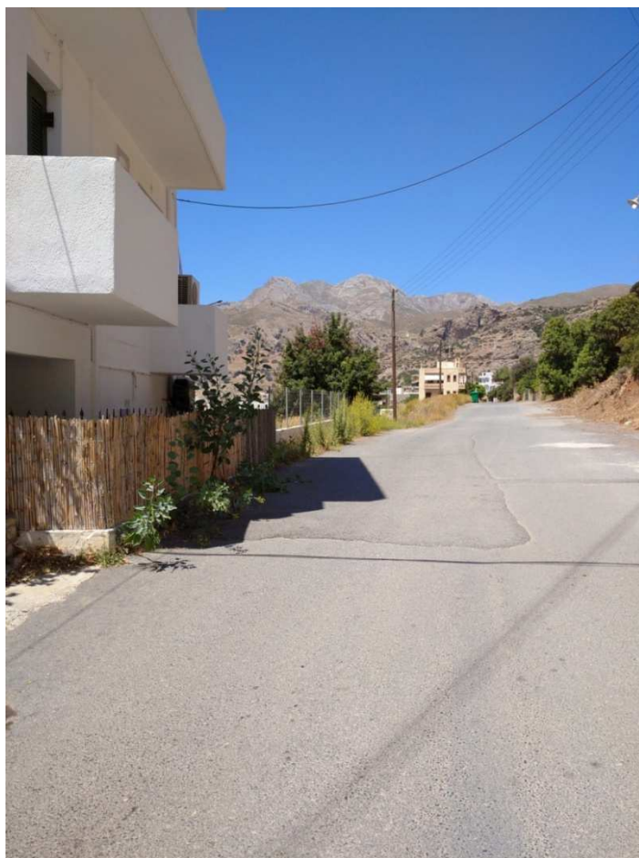
Κατασκευή πεζοδρομίων από την αριστερά πλευρά (νότια) και τοποθέτηση παγκάκια
