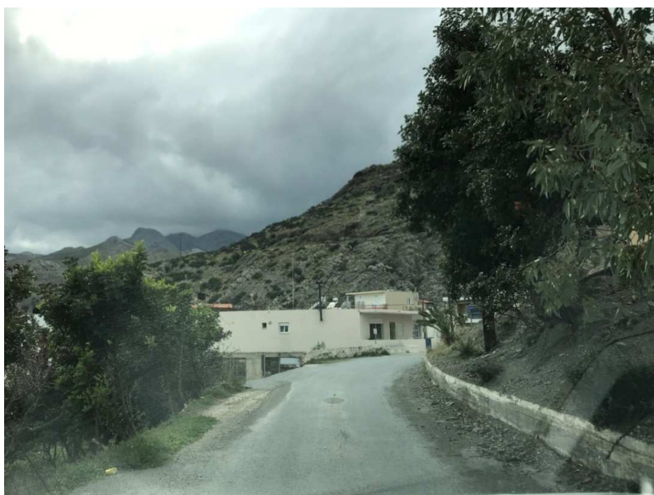
Θέση τοίχου αντιστήριξης αριστερά (νότια)
