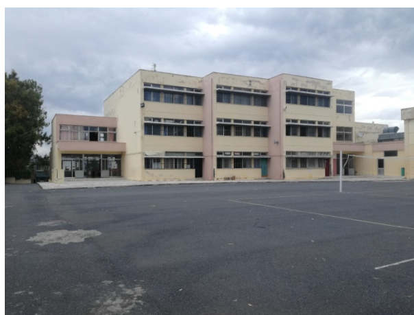
Εικόνα 2: Νότια όψη του υπό-μελέτη κτιρίου.
