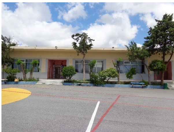
Εικόνα 3: Νότια όψη του Κτιρίου 2ου 1 ου Δημοτικού Σχολείου Αρκαλοχωρίου.
